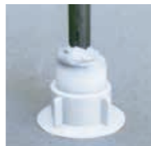
ブチルに丸セパレーターを挿入
