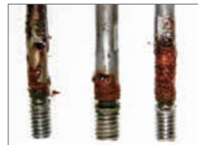
内部丸セパレーターに錆の発生はない
