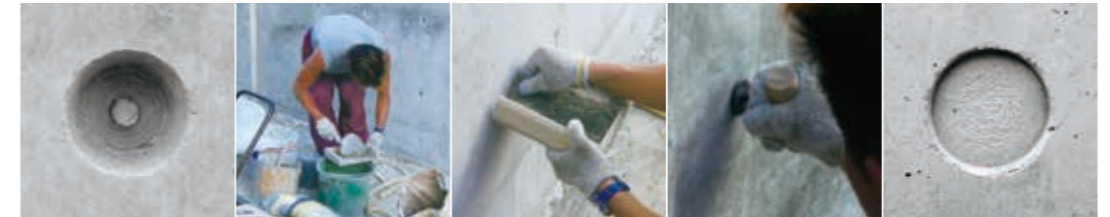
①Pコン穴 ②モルタル練り混ぜ ③モルタル穴埋め ④モルタルコテ仕上げ ⑤仕上り
