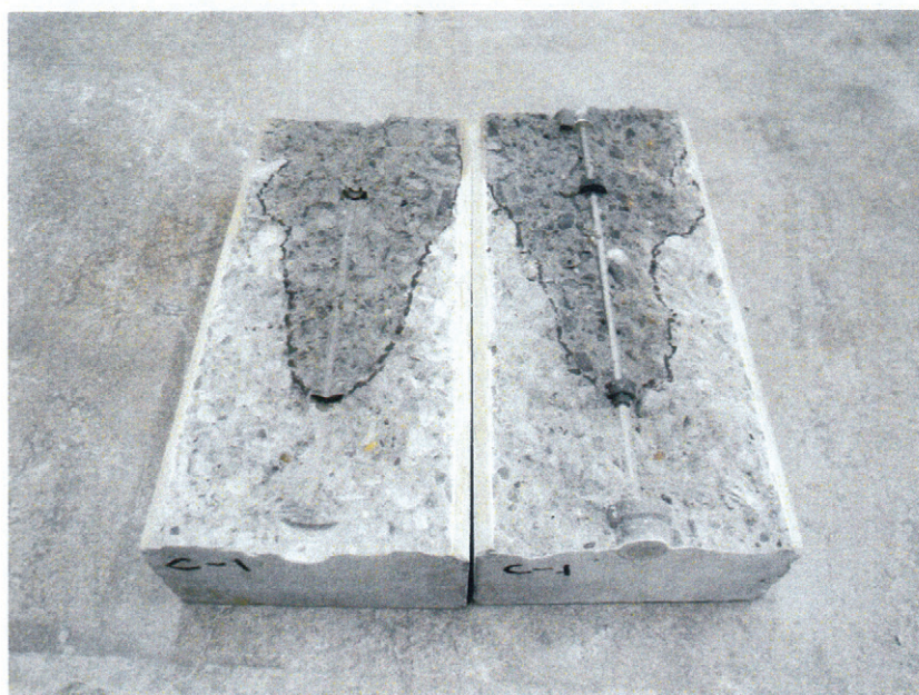
写真-8 割裂面の状況 試験体記号：C-1
