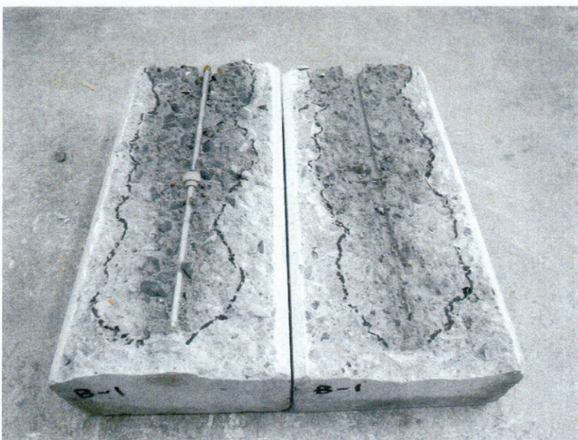
写真-6 割裂面の状況 試験体記号：B-1
